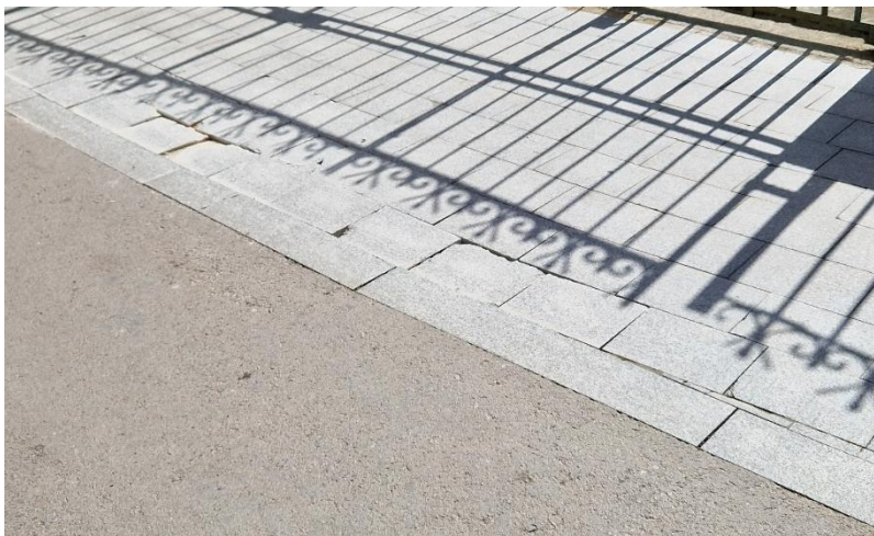
Imatge 04. Paviment enfonsat i amb arestes
