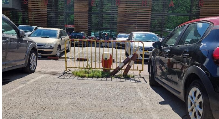
Imatge 05. Hidrant al pàrquing de centre comercial Boya
