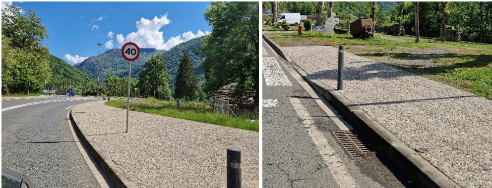
Imatge 06. Zona d'instal·lació de pilones a l'avinguda Sant Jaume
